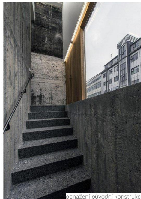
obnažení původní konstrukce
