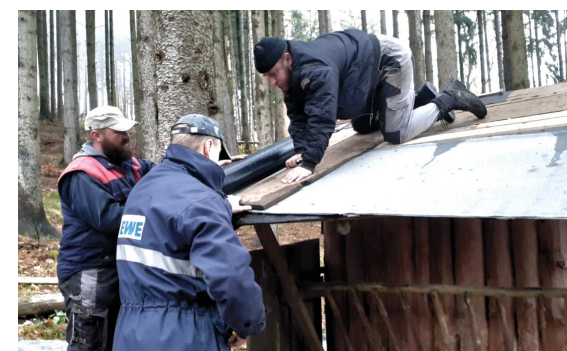
Opravení střechy krmelce (foto V. Rott)
