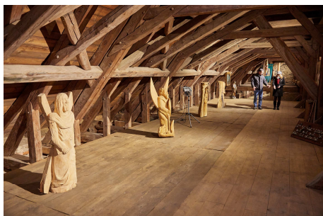
Na opravené půdě kostela je výstava soch
