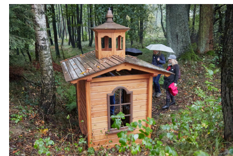
Nově zastřešená studánka na naučné stezce
