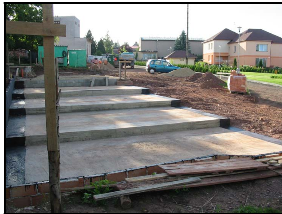
Výstavba garáží u nových bytových domů
