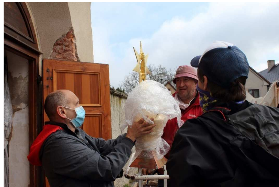
Usazení schránky na střechu 30.4.2020
